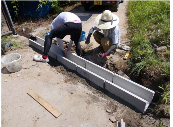
U字溝設置
