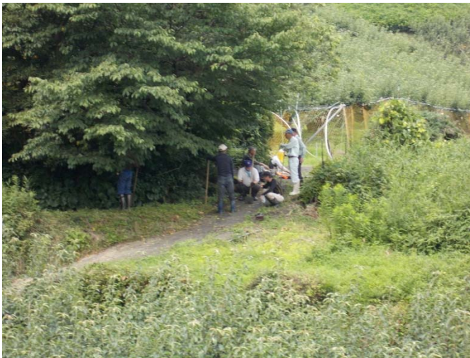
水路の草刈り作業途中の小休憩
