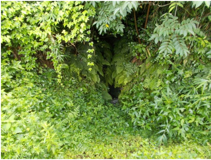
ため池から新井出暗渠注入口の泥上げ
