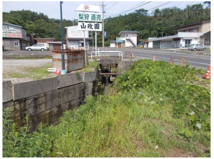
新井出暗渠出口水路の泥上げ
