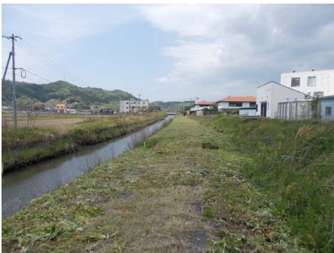
河川土手（西海士付近）の草刈り作業後
