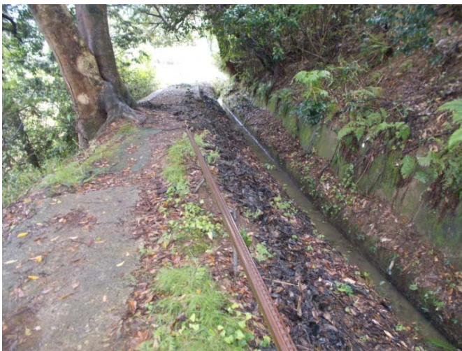
水路の泥上げ後
