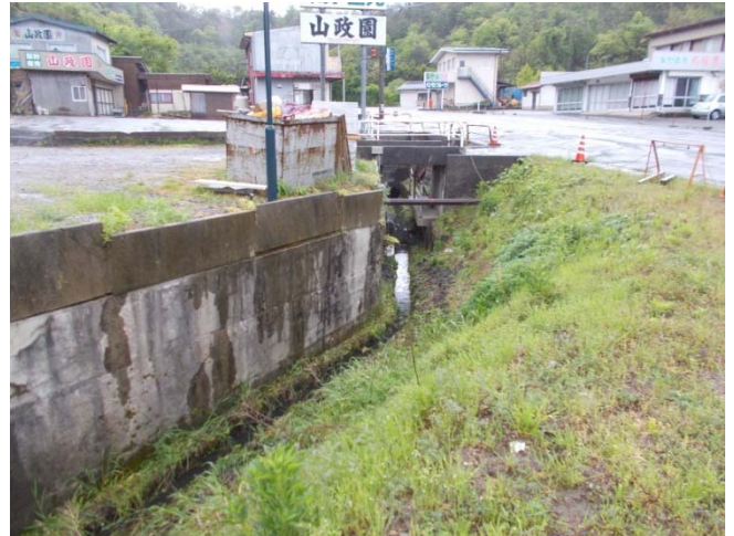
新井出暗渠出口水路の泥上げ
