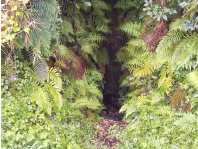
ため池から新井出暗渠注入口の泥上げ
