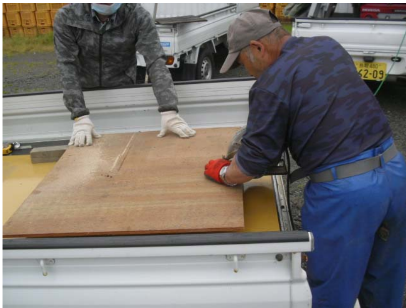
水路の堰板の作成
