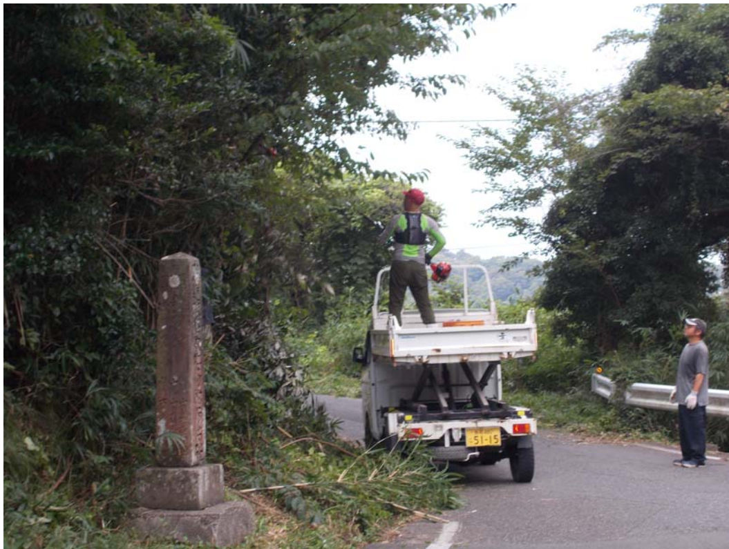
たれ枝の伐採（軽トラダンプと高枝チェンソー）
