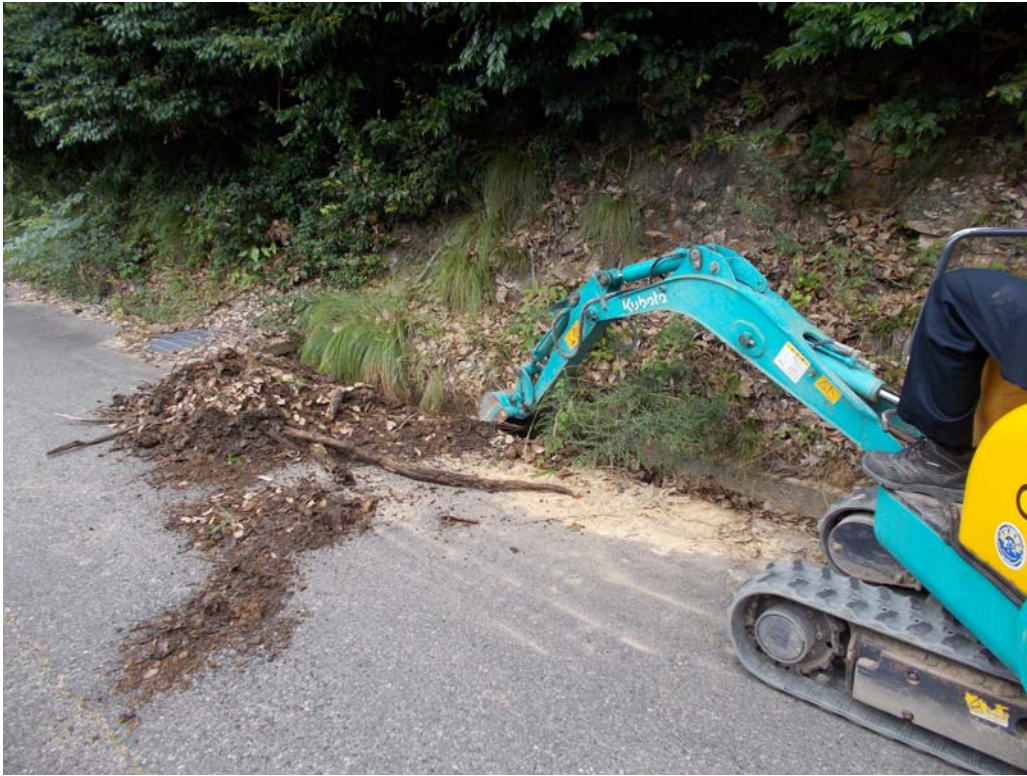
道路側溝の泥上げ作業
